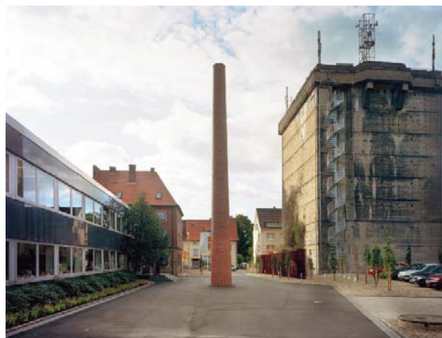
"Den nionde skorstenen", 18 m, Firma Jäckering, Hamm, Tyskland 2008
